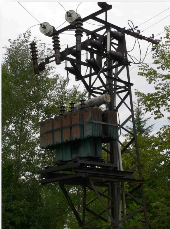
obr. 54: lokální transformační stanice
