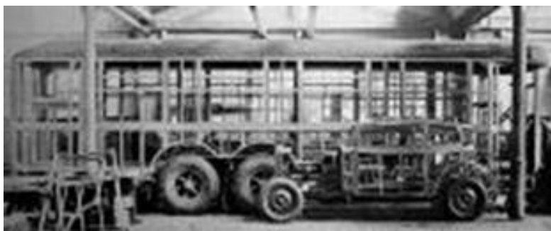
Příklady tenkostěnných profilů k výrobě koster
